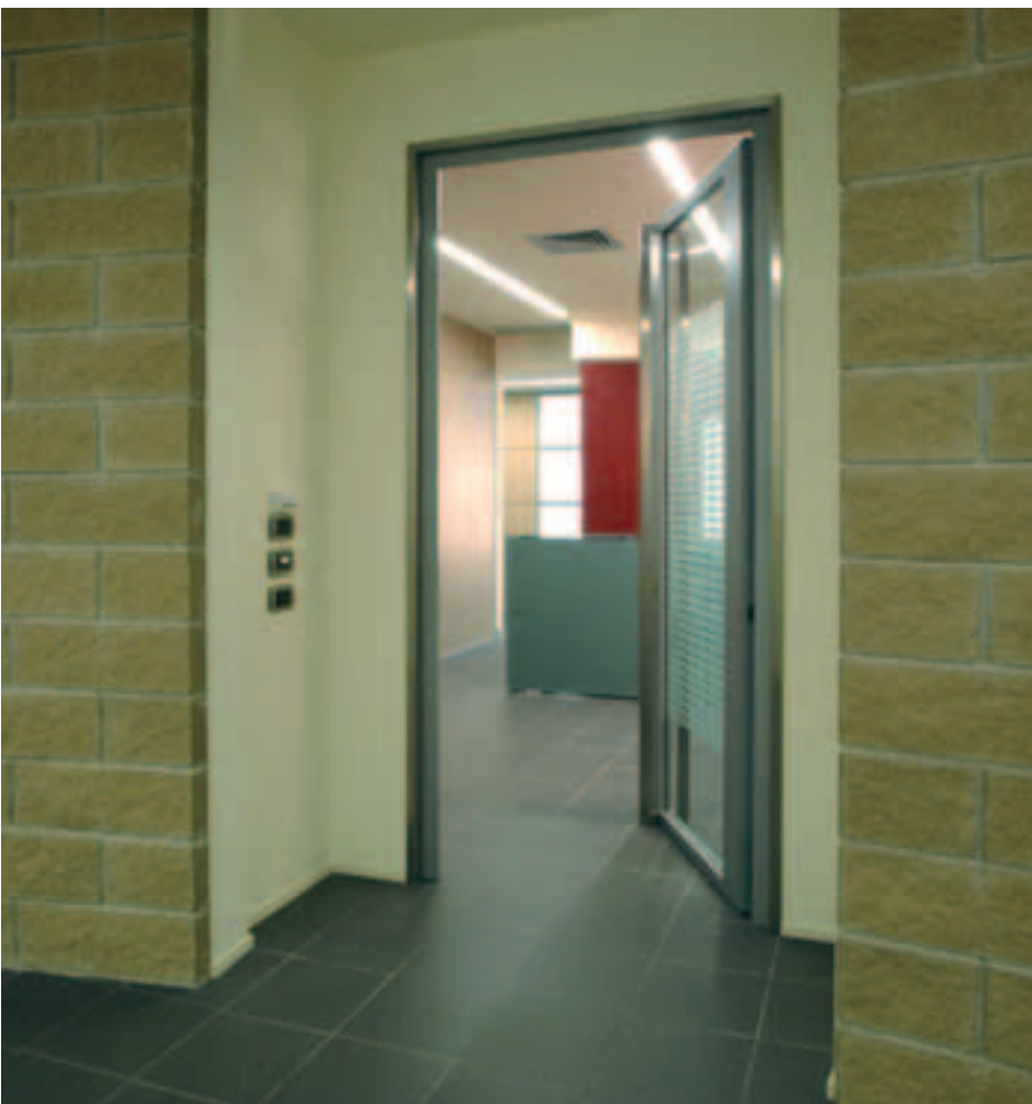
■ Per la funzione di controllo accessi, gli ingressi alla sede delle due società sono dotati di lettori di tessere a transponder interfacciati con il sistema di building automation.
